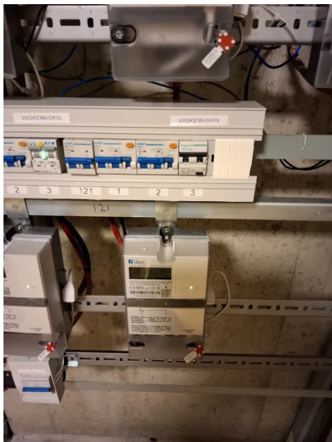
Sikringer tilhørende leiligheten er plassert i felles sikringsskap.
