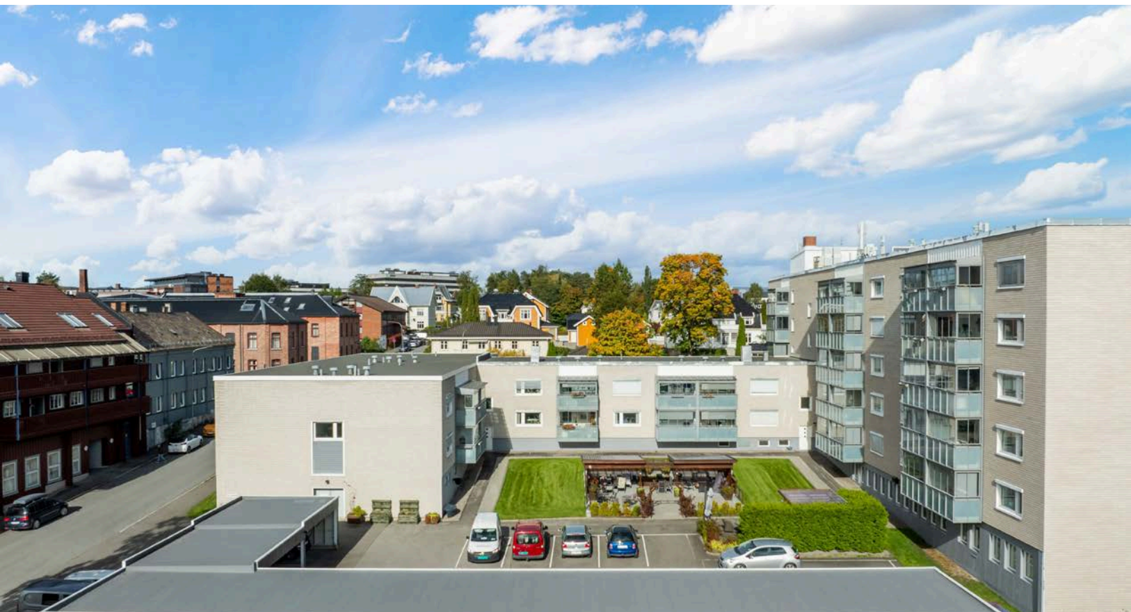
Utearealene til borettslaget er pent opparbeidet.
