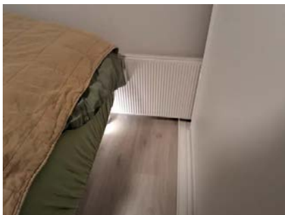
Leiligheten er oppvarmet med radiatorer tilknyttet fjernvarme.
