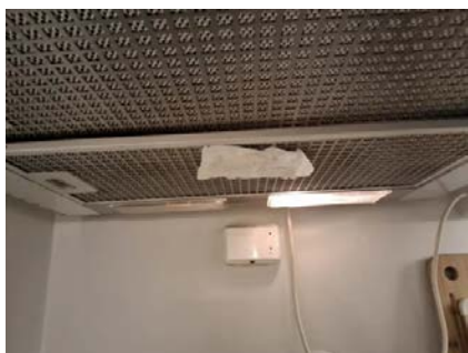
Avtrekkseffekt er testet med papir.
