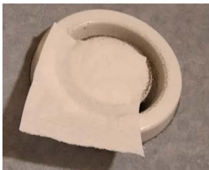
Avtrekkseffekten er testet med papir.
