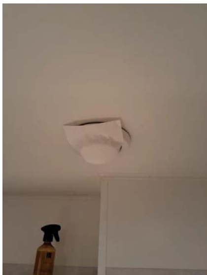
Avtrekkseffekt er testet med papir.
