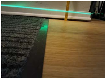
Det registreres glippe mellom gul og gulvlist som følge av ujevnt gulv.
