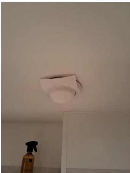
Avtrekkseffekt er testet med papir.
