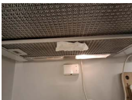
Avtrekkseffekt er testet med papir.
