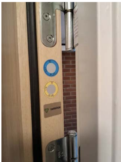
Leiligheten har entrédør med brannklasse B-30 og lydklasse 35 dB.
