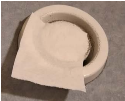
Avtrekkseffekten er testet med papir.
