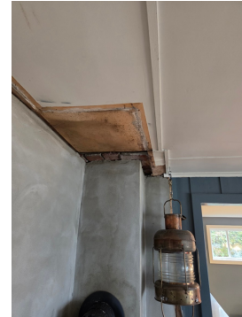
Skader etter lekkasje rundt pipe.
