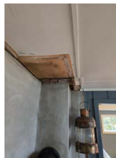
Skader etter lekkasje rundt pipe.
