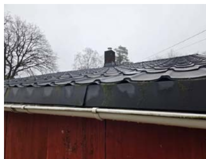
Skader etter lekkasje rundt pipe.
