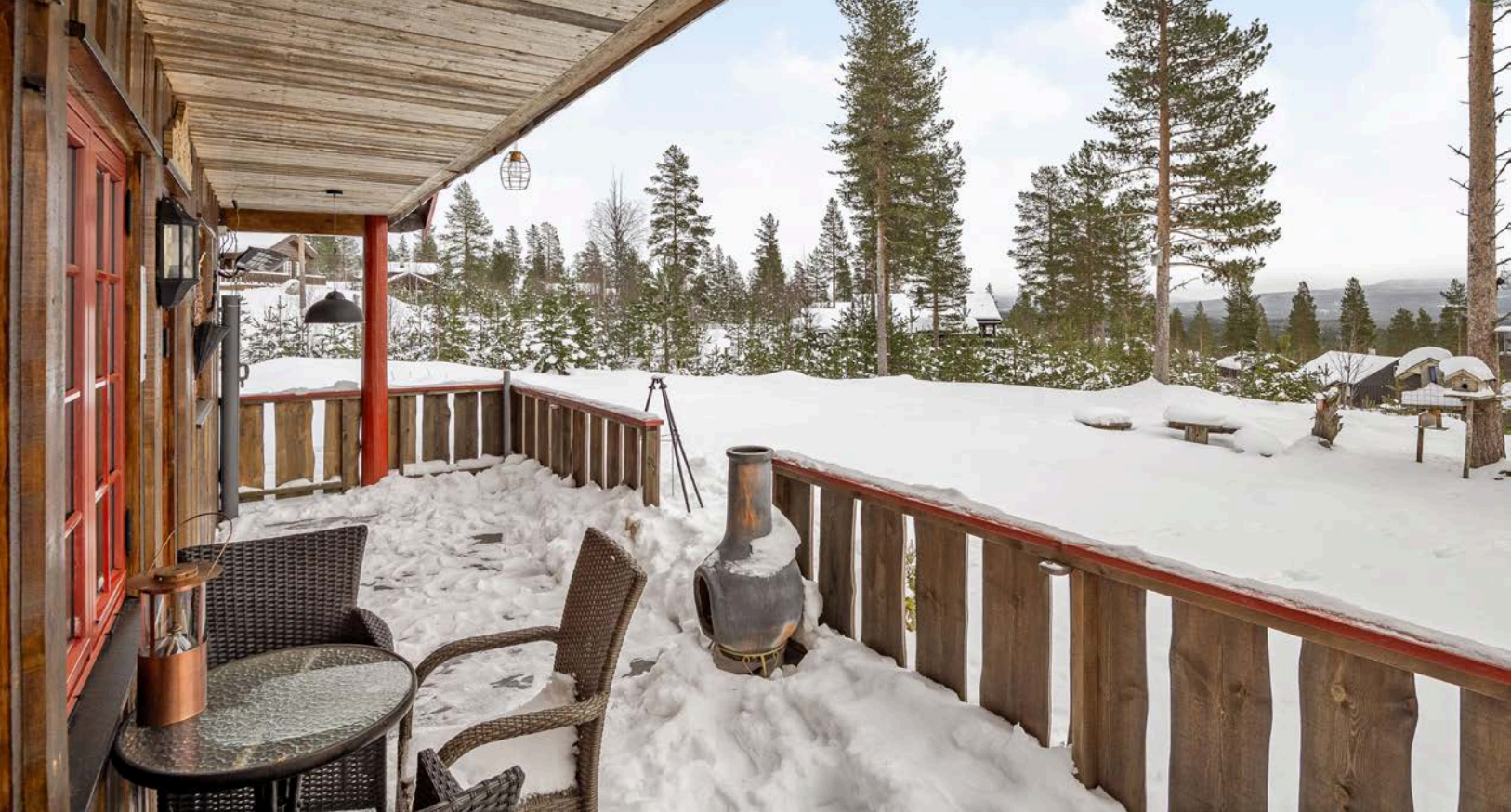
Terrassen som er overbygget har terrassebord på gulv og rekkverk av villmarkspanel. Det er også montert uttrekkbar levegg og utebelysning.
