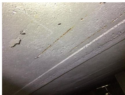
Armeringskorrosjon.
