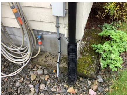
Bilde av betongforsterkning fra utside. Ukjent når dette er utført og om det har ønsket effekt på forsterkning av den eksisterende murveggen.
