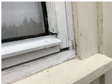
Eksempel på vindu fra byggeår.
