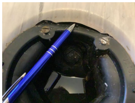
Belegg/membran har utett løsning mot sluk.
