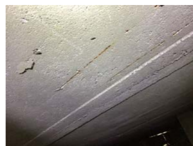
Armeringskorrosjon.
