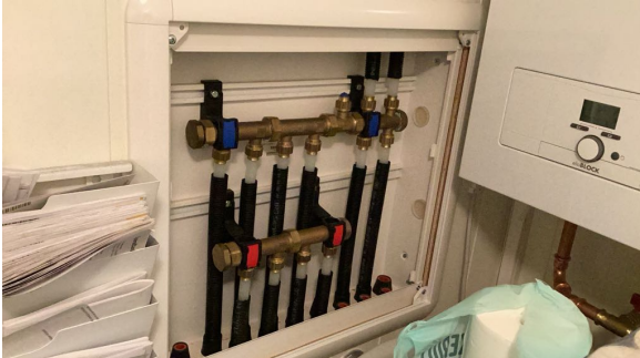
Kontroll av rørskap.
