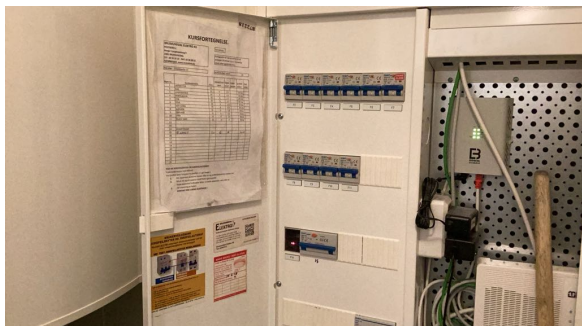
Kontroll av skap.
