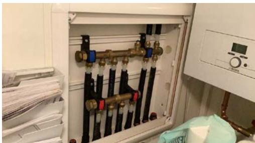
Kontroll av rørskap.
