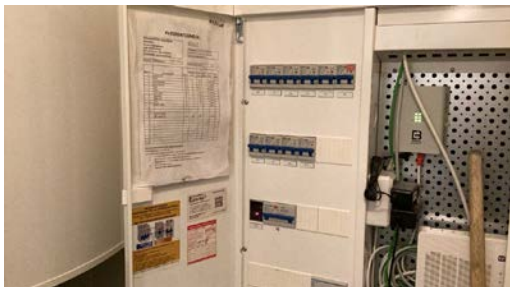
Kontroll av skap.
