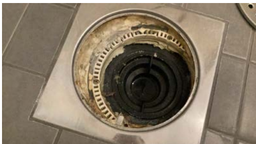
Kontroll av sluk.
