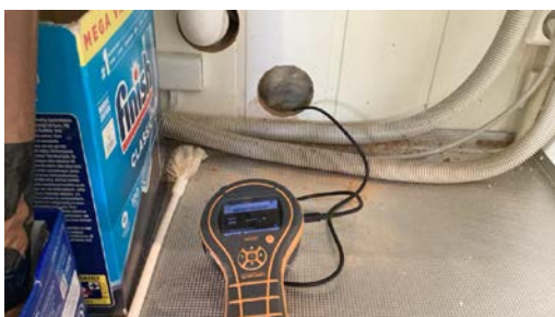
Ved fuktmåling ble det registrert tørre verdier.
