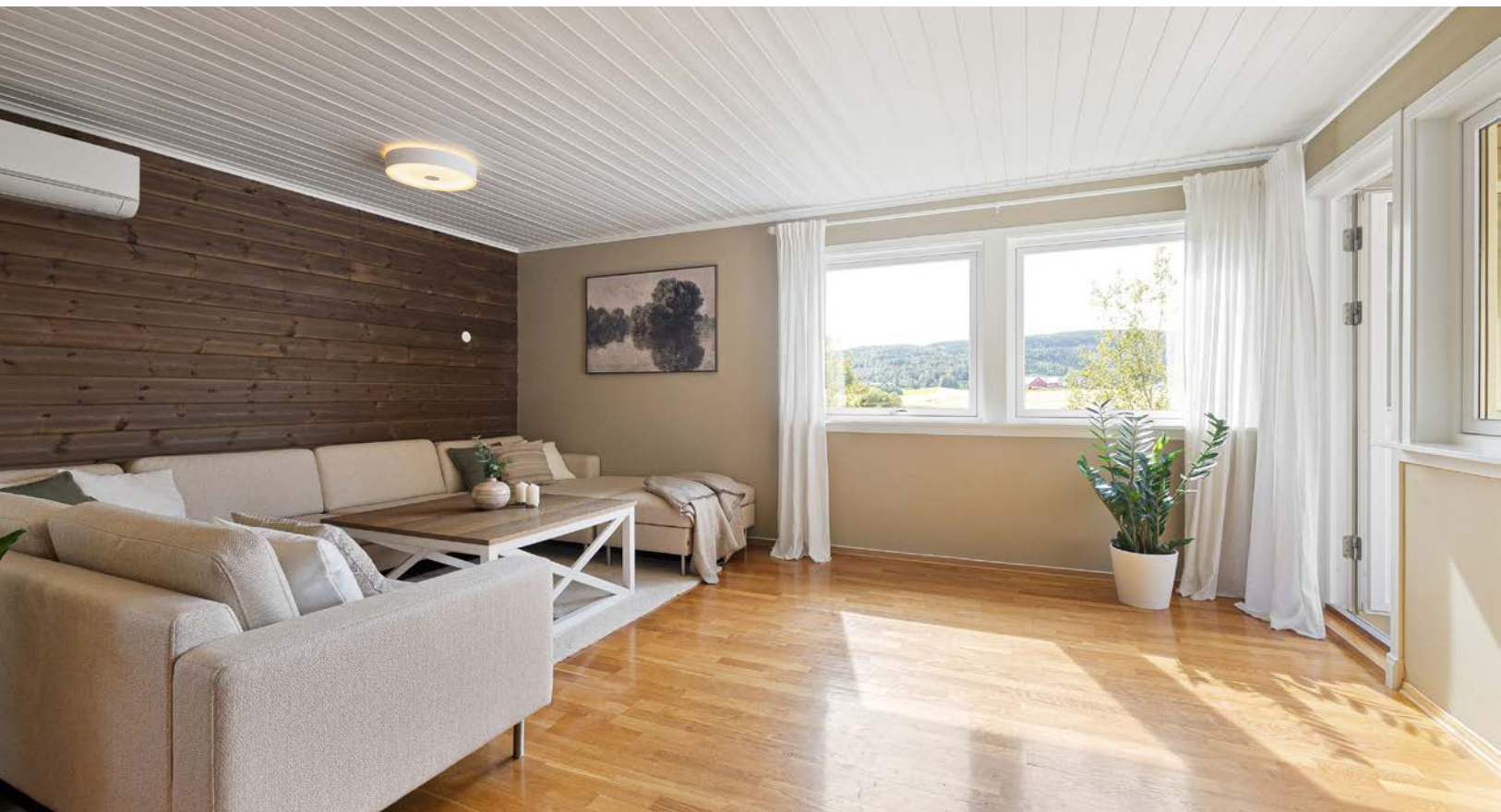
Det er installert varmepumpe i stuen.
