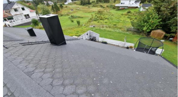
Visuell besiktelse av taket.
