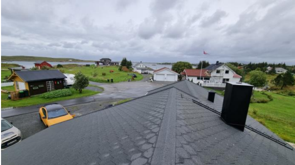
Visuell besiktelse av taket.
