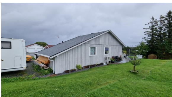
Svak skråning inn mot boligens sørvest-side.
