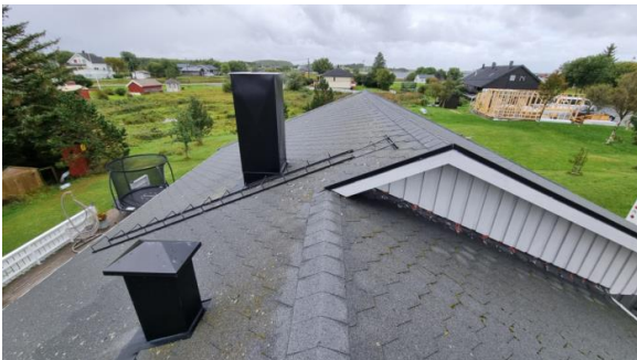
Visuell besiktelse av taket.
