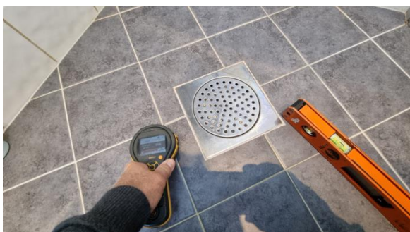
Fuktmåling og kontroll av fall mot sluk.
