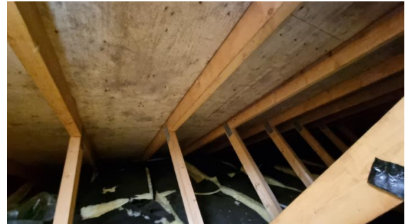
Stedvis svertesopp i finerplater.
