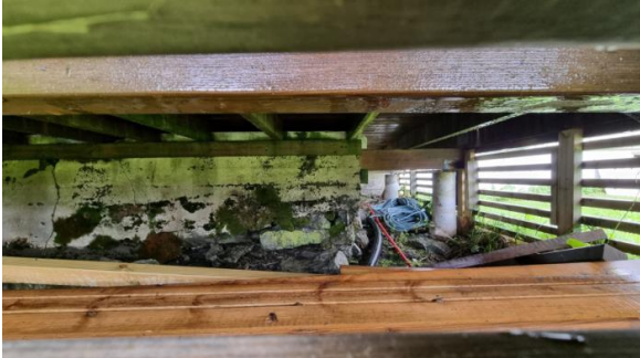
Kontroll av fundamenteringen under terrassen.
