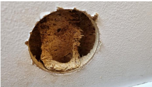
Innvendige skillevegger av formpressede veggelementer.
