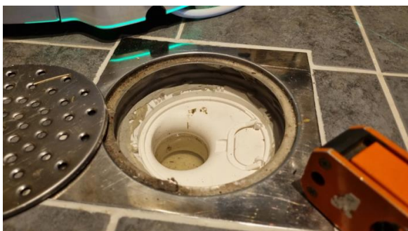
Kontroll av sluk.
