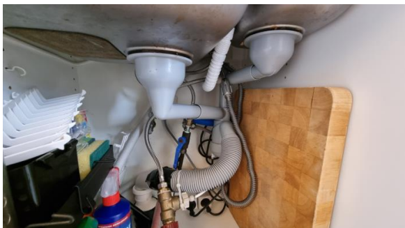
Kontroll av røropplegg under oppvaskkummen.
