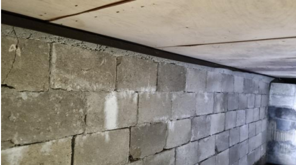
Inspeksjon av krypkjeller.
