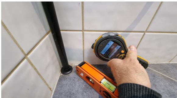
Fuktmåling i vegger.
