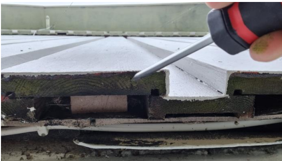
Kontroll av ytterkledningen.
