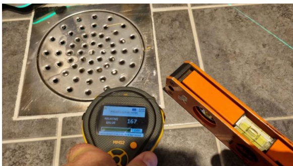
Fuktmåling og kontroll av fall mot sluk.
