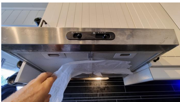
Funksjonstesting av det mekaniske avtrekket over koketoppen.
