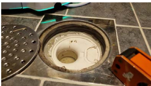
Kontroll av sluk.
