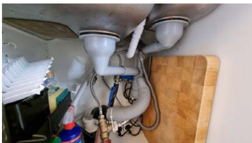
Kontroll av røropplegg under oppvaskkummen.
