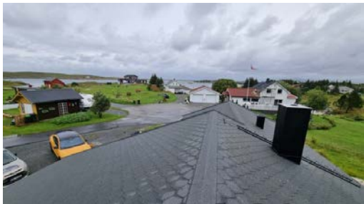
Visuell besiktelse av taket.
