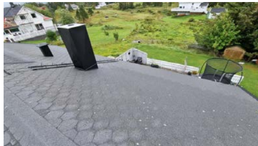
Visuell besiktelse av taket.
