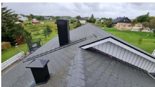
Visuell besiktelse av taket.
