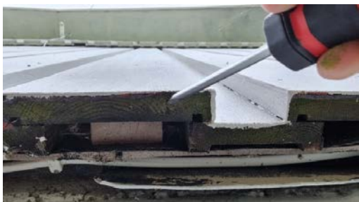
Kontroll av ytterkledningen.
