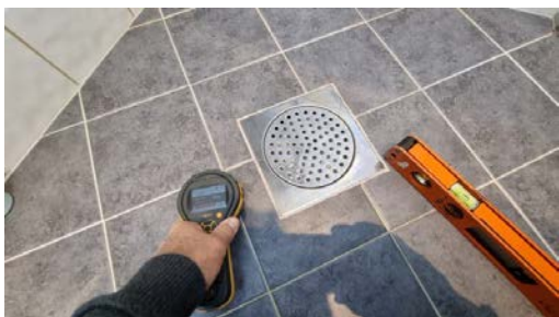
Fuktmåling og kontroll av fall mot sluk.
