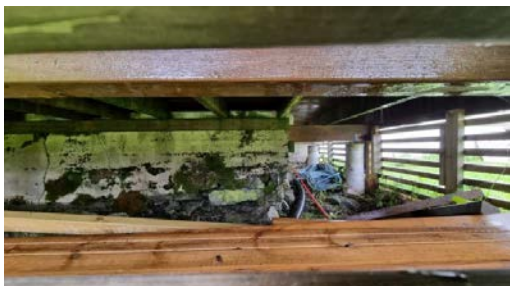
Kontroll av fundamenteringen under terrassen.
