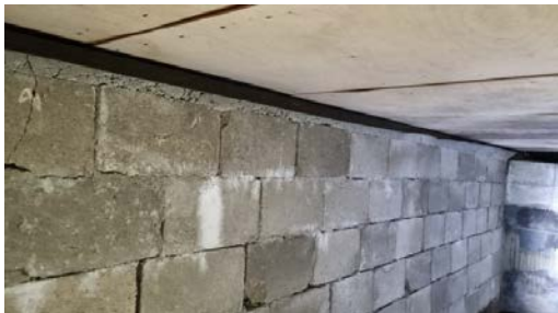
Inspeksjon av krypkjeller.
