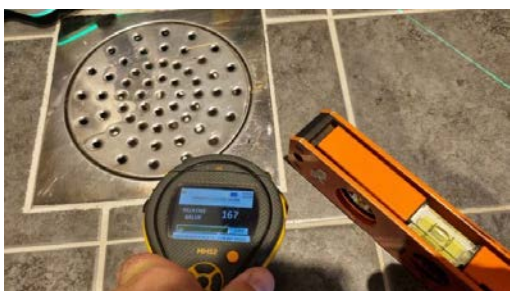
Fuktmåling og kontroll av fall mot sluk.
