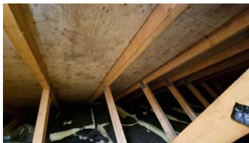
Stedvis svertesopp i finerplater.
