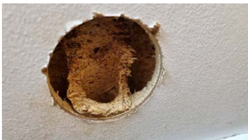
Innvendige skillevegger av formpressede veggelementer.
