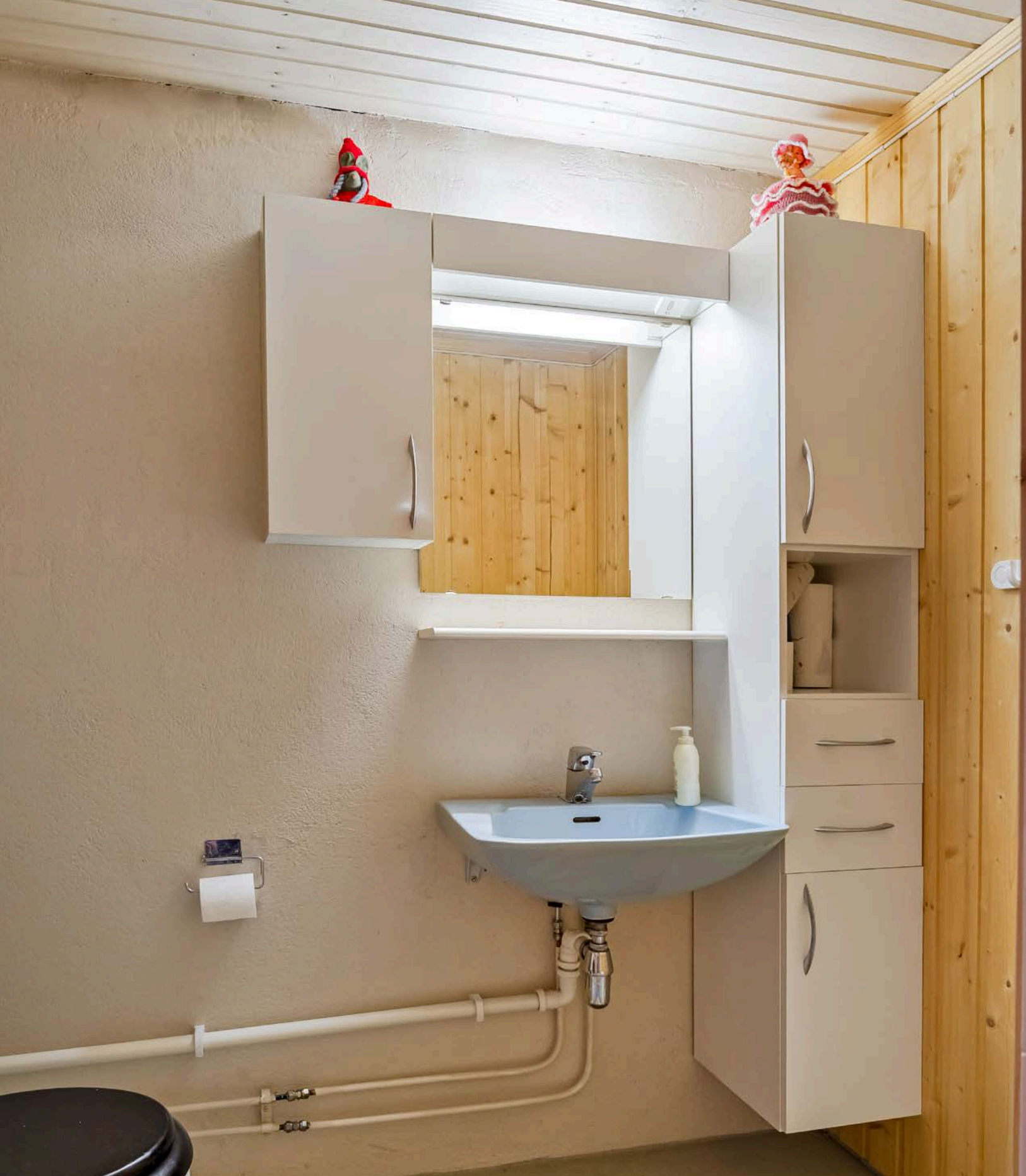
Ekstra toalettrom i kjeller med vinylbelegg på gulv og malt murpuss på veggene. Rommet er utstyrt med vegghengt servant, speil med belysning og vegghengte skap over, samt gulvstående toalett.
