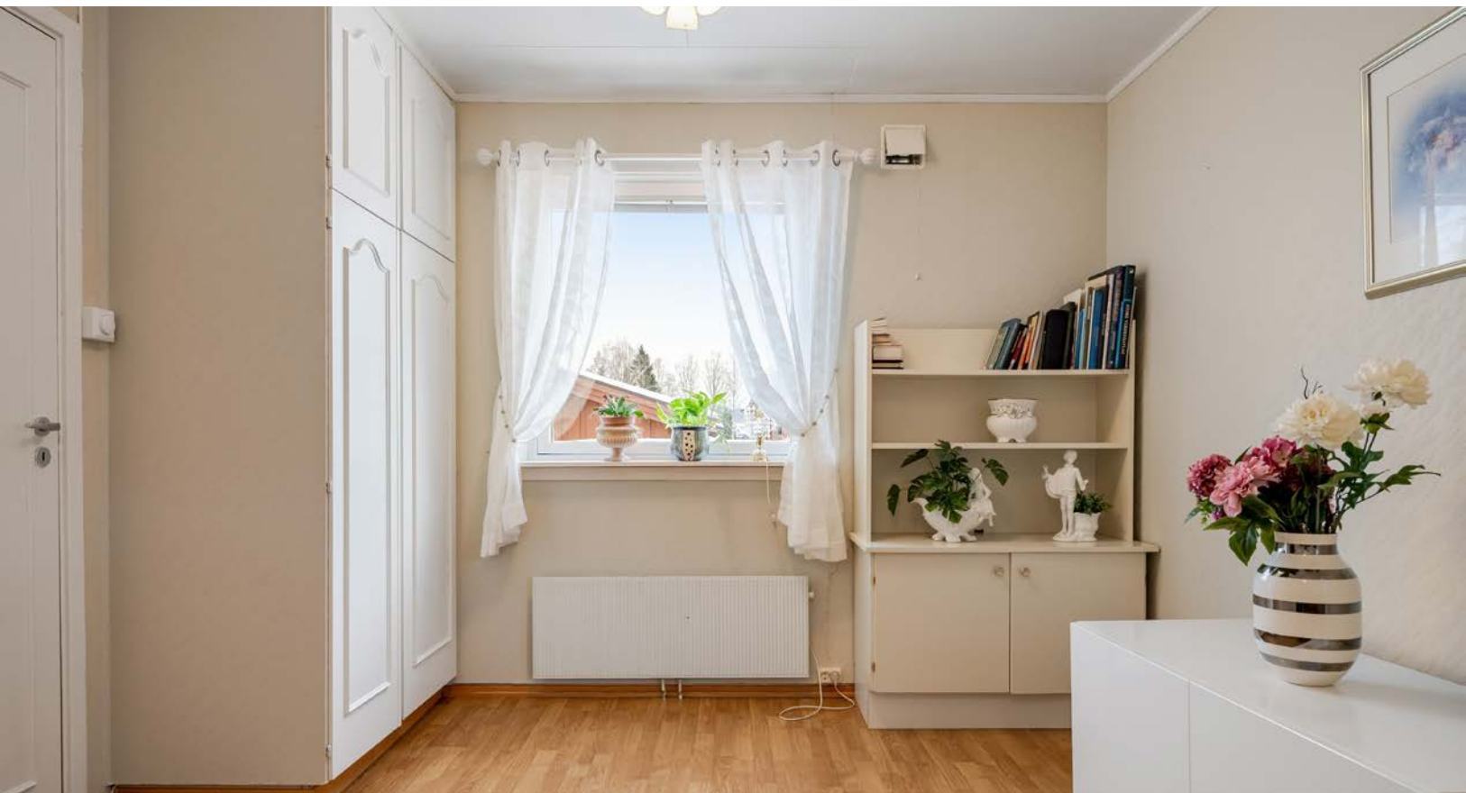
Luft-til-vann varmepumpe med innebygget varmtvannsbereder. Eier opplyser: Varmtvannsbereder var opprinnelig i sentralfyr drevet med olje. Gikk over til luft/vann i 2009. Utført av: firma.
