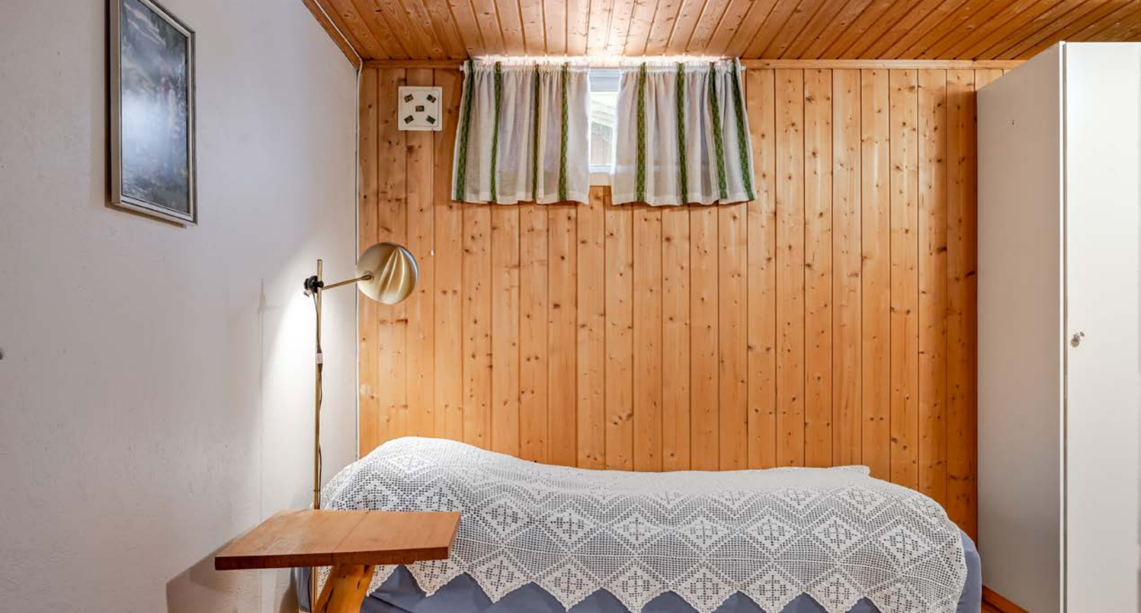
Det gjøres oppmerksom på at soverom og kjellerstue i kjeller har ikke godkjente rømningsvinduer.
