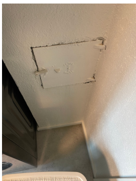
Avstand til brennbart under forskriftskrav.
