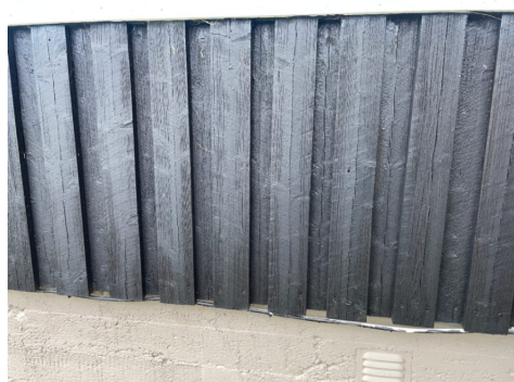
Værslitt/oppsprukket ytterkledning
