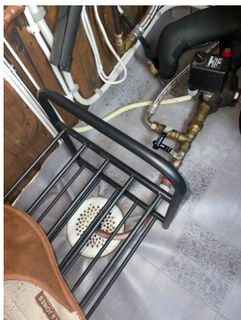
Ufaglig montering av vinylbelegg.
