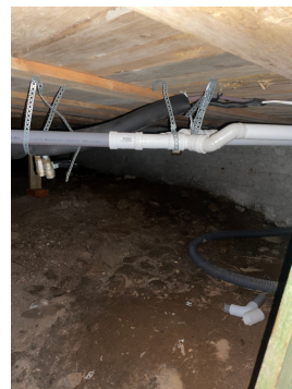
Avløpsrør er festet med patentbånd
