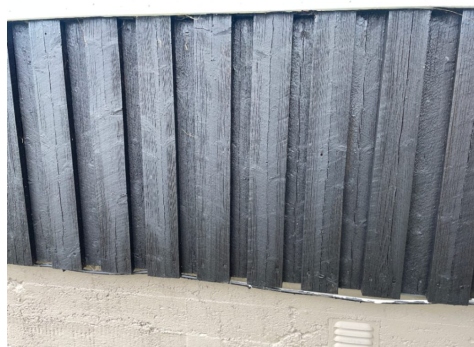
Stedvis løs strømførende ledning.
