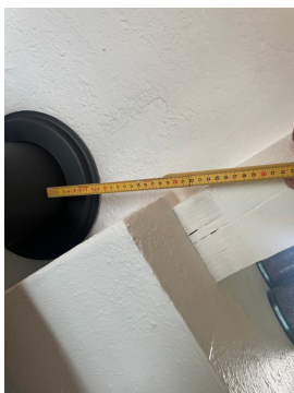
Avstand til brennbart under forskriftskrav.
