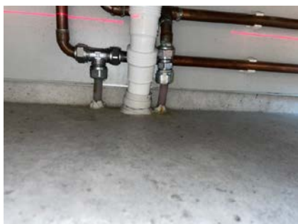
Ufaglig tetting rundt rørgjennomføringer i våtsoner.
