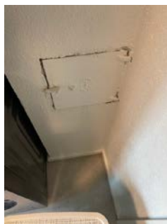
Avstand til brennbart under forskriftskrav.
