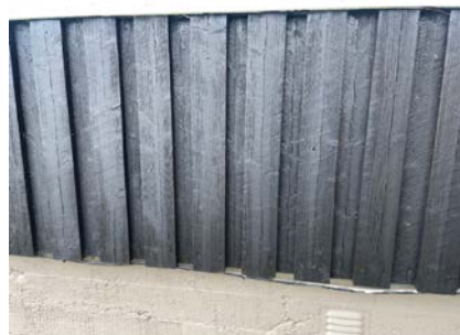
Stedvis løs strømførende ledning.
