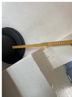
Avstand til brennbart under forskriftskrav.
