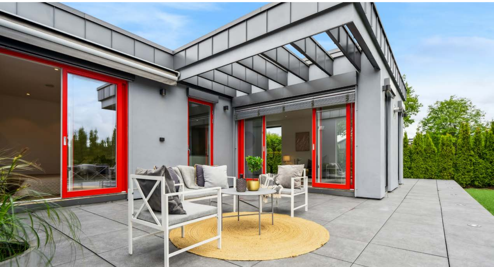
Terrassen har flisebelagt systemgulv med justerbare bein, samt belysning langs gulvet.
