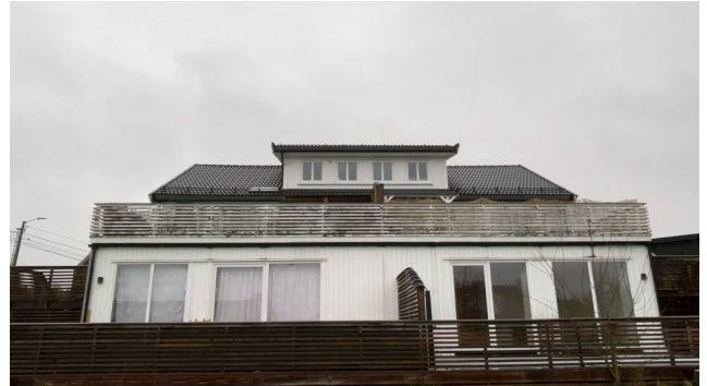
Besiktigelse av taktekke.
