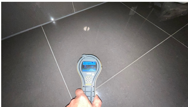
Utført fuktsøk på overflater.
