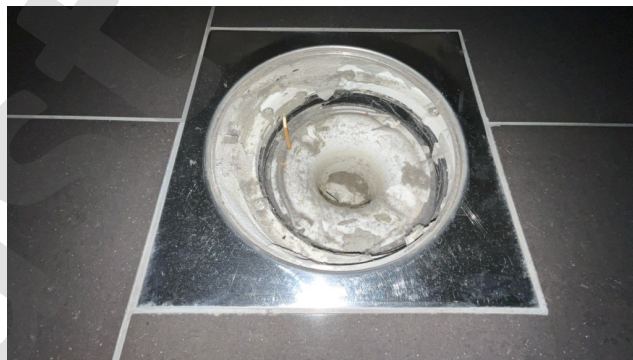
Kontroll av sluk.
