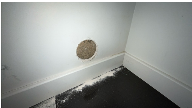
Utført hulltaking. Bakenforliggende murkonstruksjon/betongvegg
