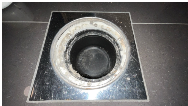
Kontroll av sluk.
