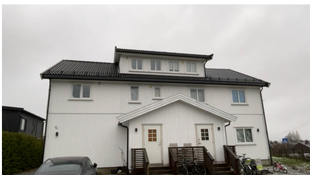
Besiktigelse av taktekke.
