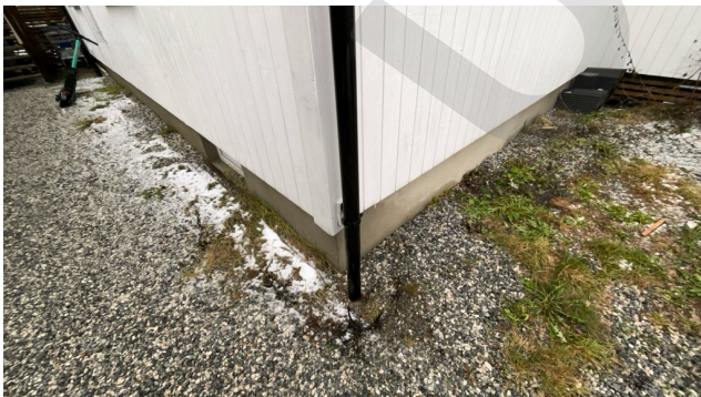
Kontroll av drenering/fuktsikring.
