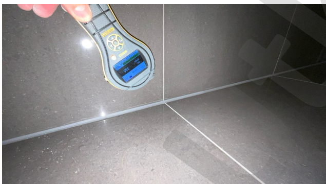
Utført fuktsøk på overflater.
