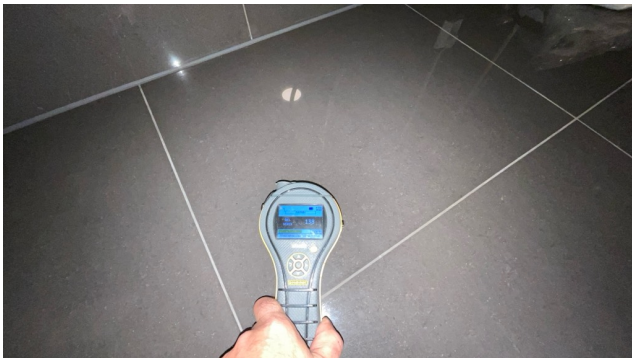
Utført fuktsøk på overflater.
