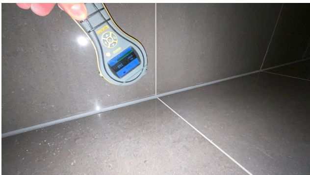
Utført fuktsøk på overflater.
