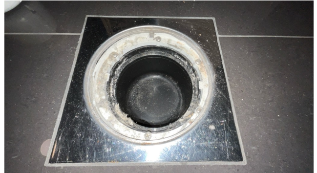
Kontroll av sluk.
