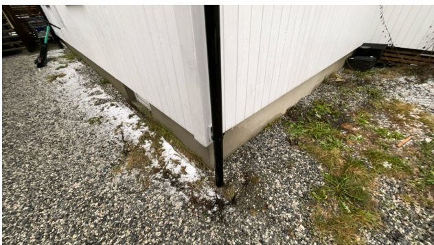
Kontroll av drenering/fuktsikring.
