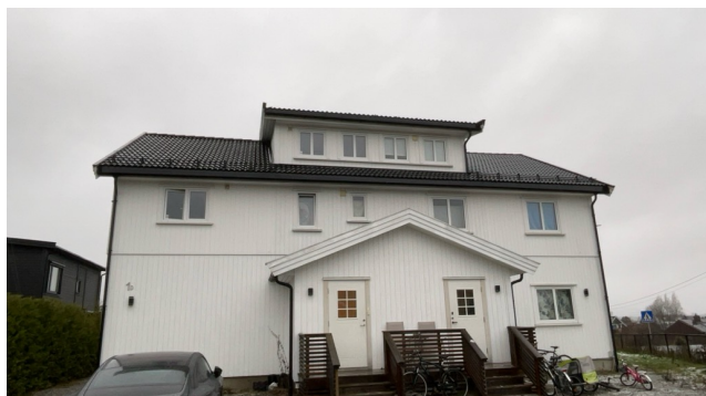
Besiktigelse av taktekke.
