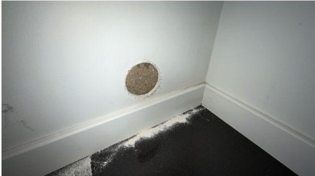
Utført hulltaking. Bakenforliggende murkonstruksjon/betongvegg
