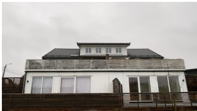
Besiktigelse av taktekke.
