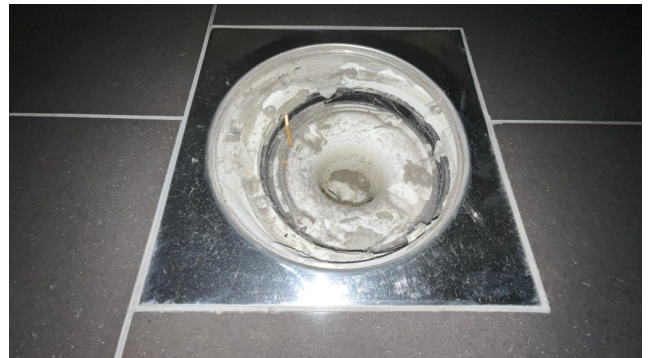
Kontroll av sluk.
