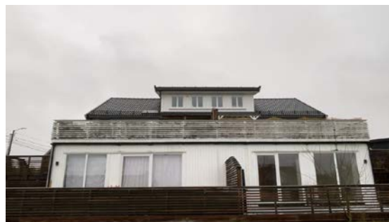
Besiktigelse av taktekke.
