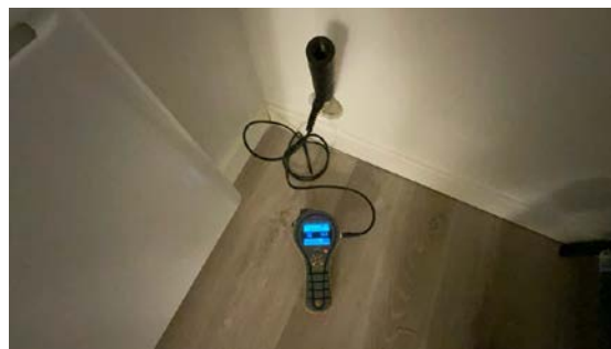
Utført hulltaking på rom under terreng.
