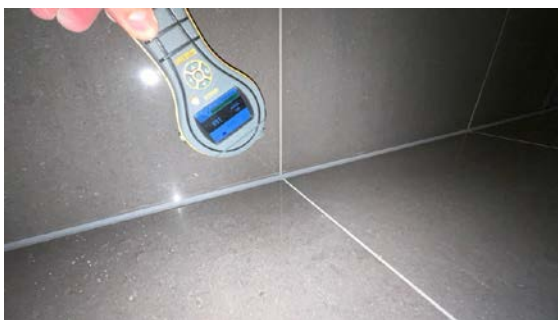
Utført fuktsøk på overflater.
