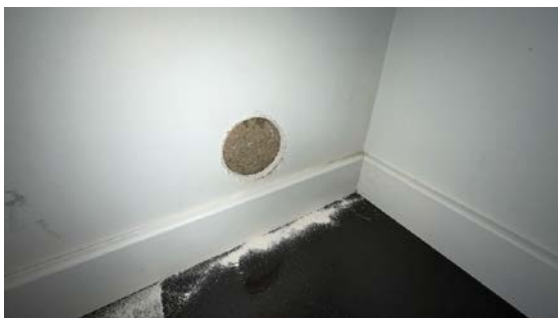
Utført hulltaking. Bakenforliggende murkonstruksjon/betongvegg
