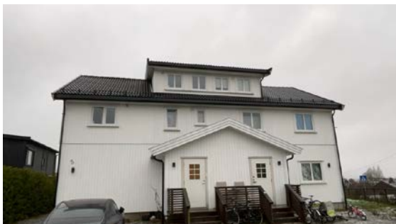
Besiktigelse av taktekke.
