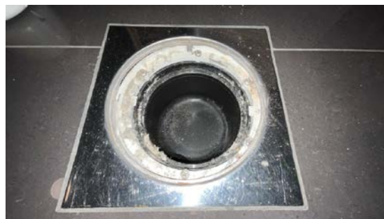
Kontroll av sluk.
