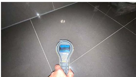
Utført fuktsøk på overflater.
