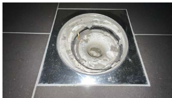
Kontroll av sluk.
