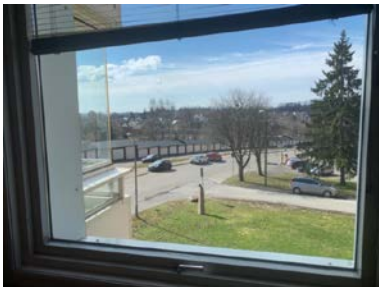
Vinduer med malt treramme
