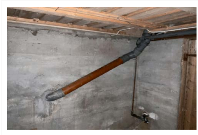
Avløp i kjeller
