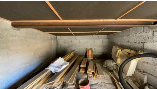
Oversikt av krypkjeller
