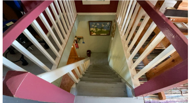
Trappen er nokså bratt og lite egnet for trapp mellom boligrom.
