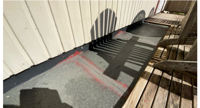
Eier har nylig overflatebehandlet skjøter mellom membran
