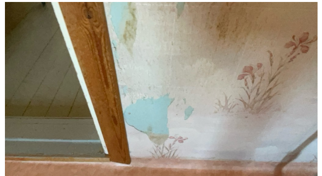
Skadet våtromstapet
