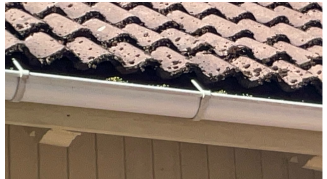
Takrenner ses stedvis fulle med vegetasjon
