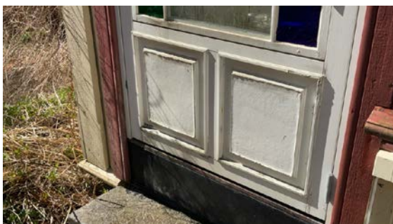
Fuktskadede dører
