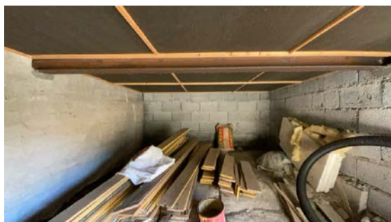
Oversikt av krypkjeller
