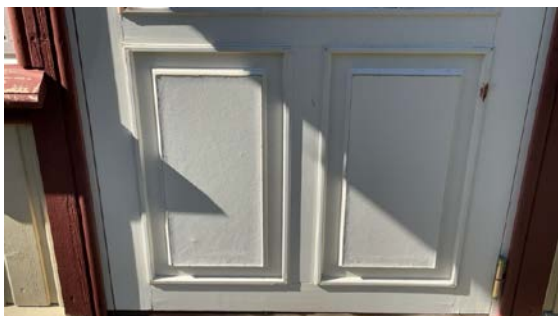
Fuktskadede dører
