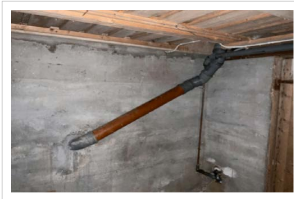
Avløp i kjeller
