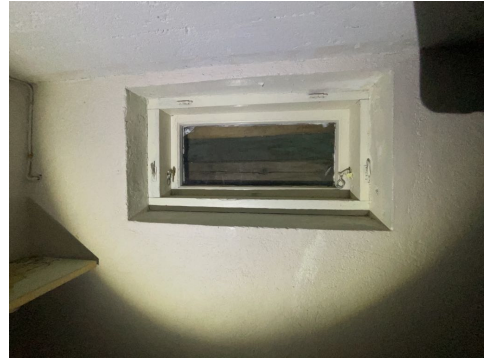
Tettet vindu som trolig leder til kryptrommet
