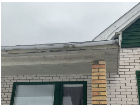
Plastrenne m/utett skjøt terrasse
