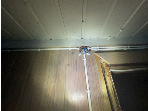
Koplingsboks garasje uten deksel
