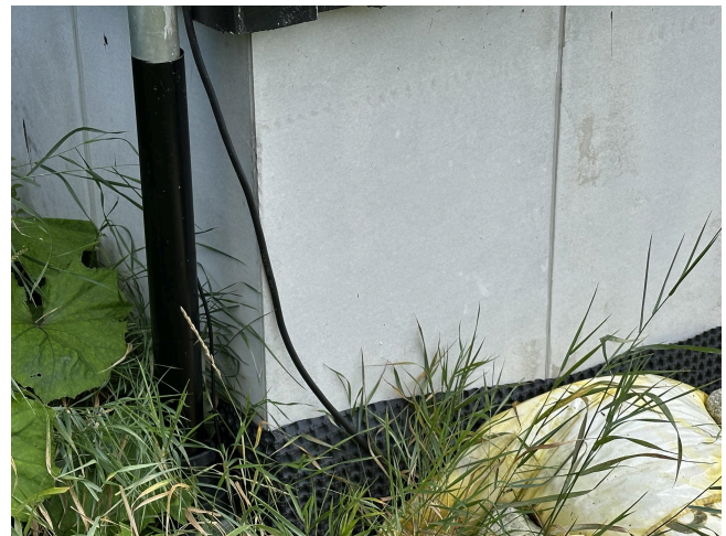
Grunnmursplast mangler topplst
