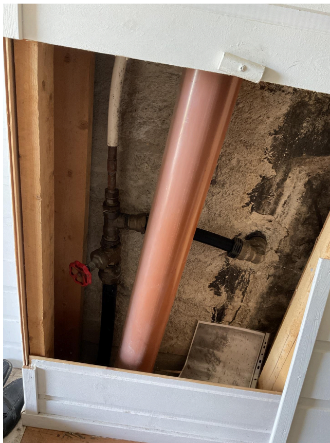
Avløp og stoppekran i avluke vegg i u.etasje. Stikkledning vann av plast.
