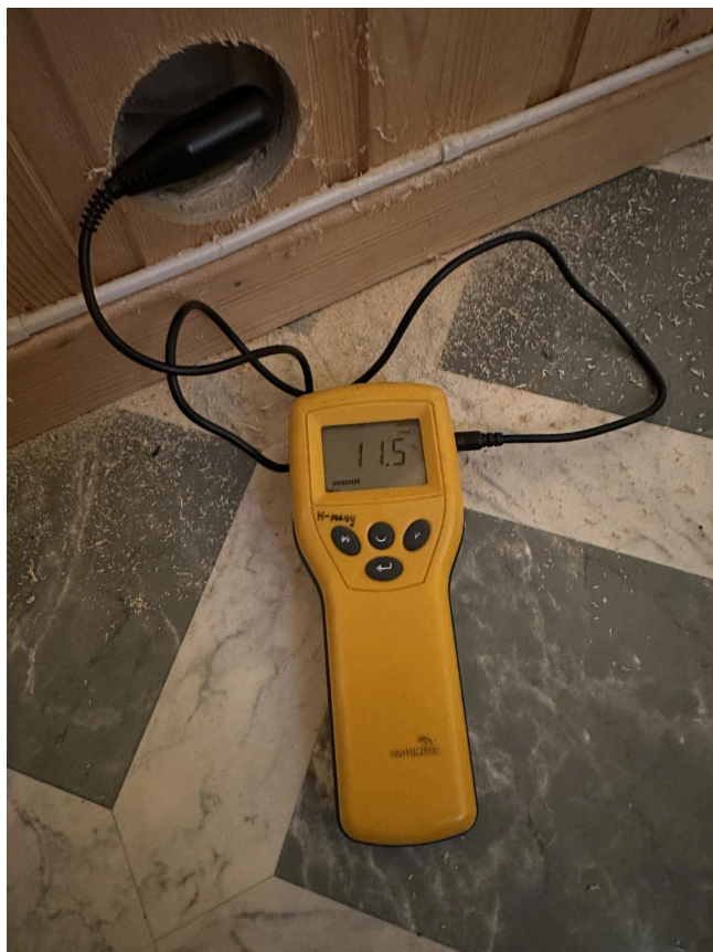
Borret et tilfeldig hull under terreng inntil svill i soverom. Ikke indikert fukt./u.etasje ved borrepunkt
