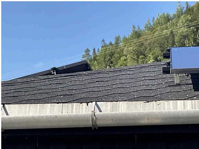
Shingelpapp som taktekke og aluminium takrenner
