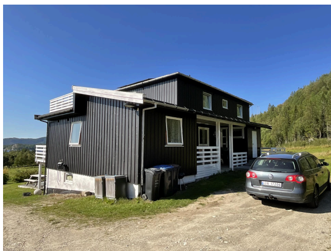
Feil helingsgrad fra grunnmur og utov
