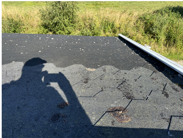
Noe mosegrad taktekke
