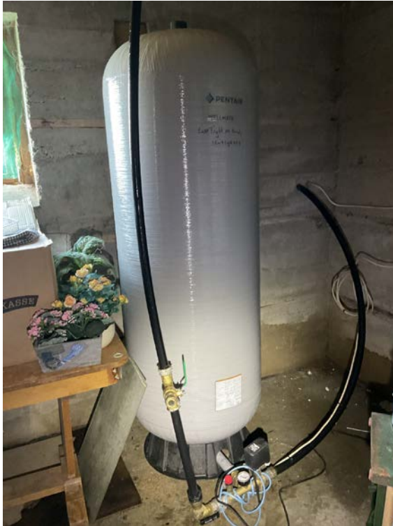
Trykktank fra 2017, stoppekrane, vann fra grunnborret vannkilde
