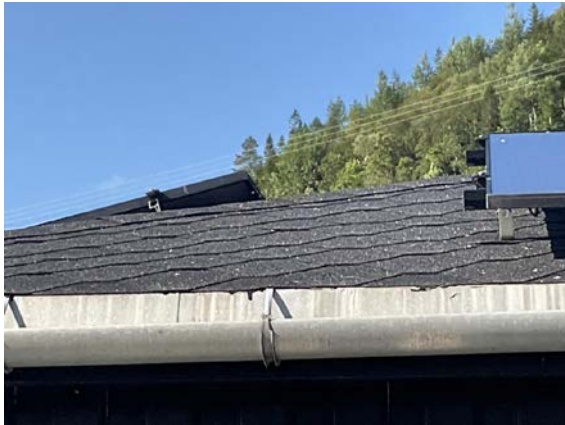
Shingelpapp som taktekke og aluminium takrenner
