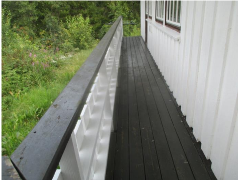
Veranda ut i fra grovkjekken
