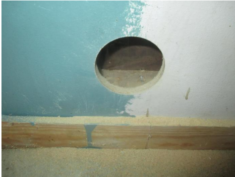
Hulltaking i fra utvendig bod.
