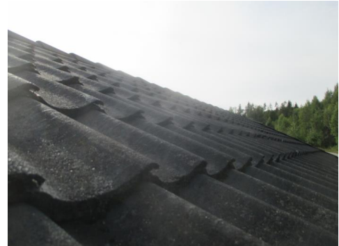
Deler av taktekingen som er vurdert i fra takvindu.
