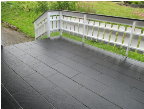
Støpt terrasse ved inngangsparti.
