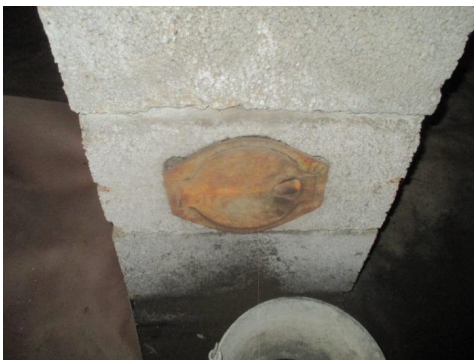
Sotluke i grovkjeller.
