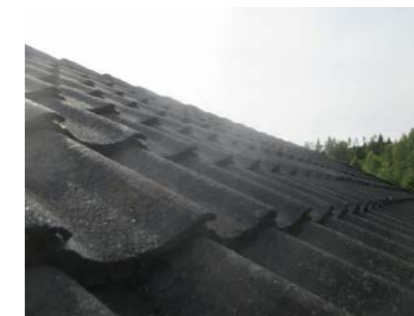
Deler av taktekkingen som er vurdert i fra takvindu.
