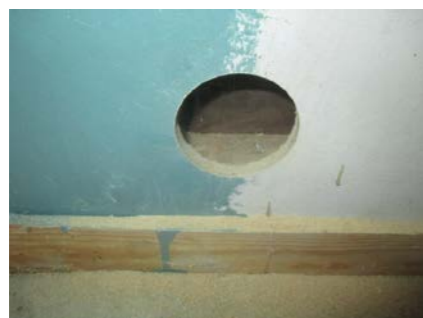
Hulltaking i fra utvendig bod.
