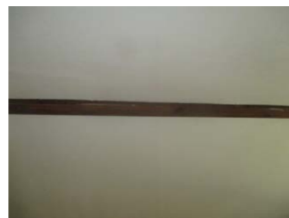
Takkonstruksjonen er en lukket konstruksjon.
