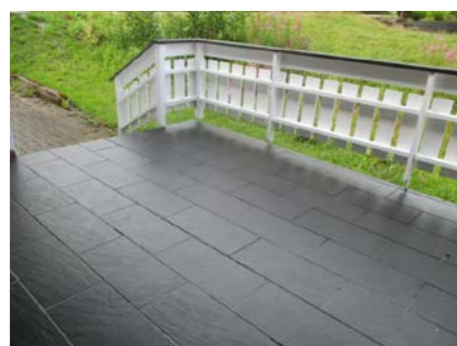
Støpt terrasse ved inngangsparti.
