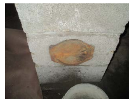
Sotluke i grovkjeller.
