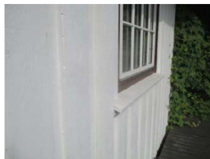
Deler av kledningen med tilhørende belistninger.
