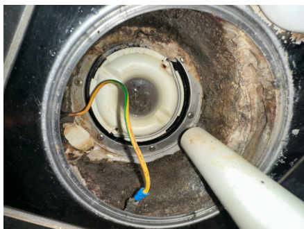
Plastsluk med klemring for membran
