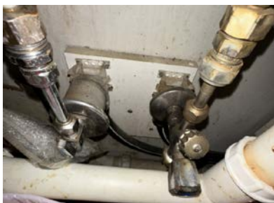
Rørøpplagg i kjøkkenbenk
