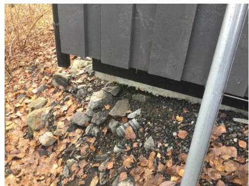
Utsiging av masser under såle.
