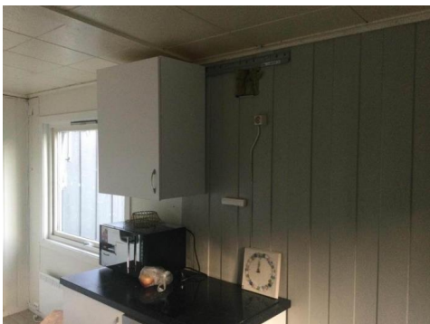
Manglende avtrekk over kokesone.
