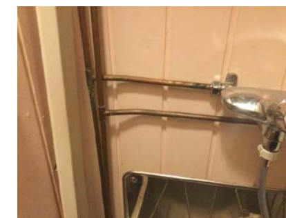
Rør ført synlig på vegg.
