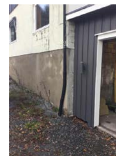
Vann ledes bort fra konstruksjonen.
