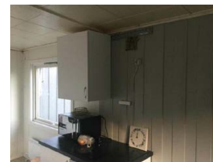
Manglende avtrekk over kokesone.
