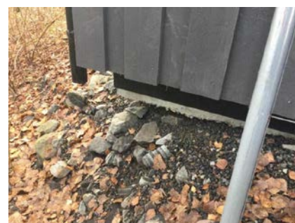
Utsigning av masser under såle.
