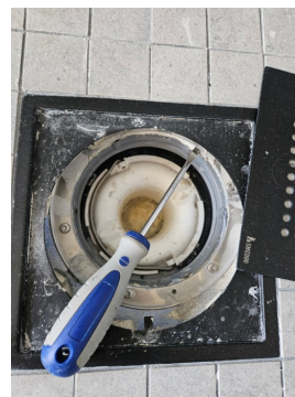
ANDRE ETASJER > BAD/VASKEROM
