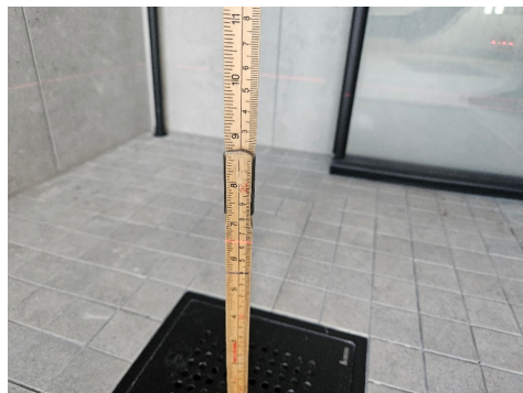
ANDRE ETASJER > BAD/VASKEROM
