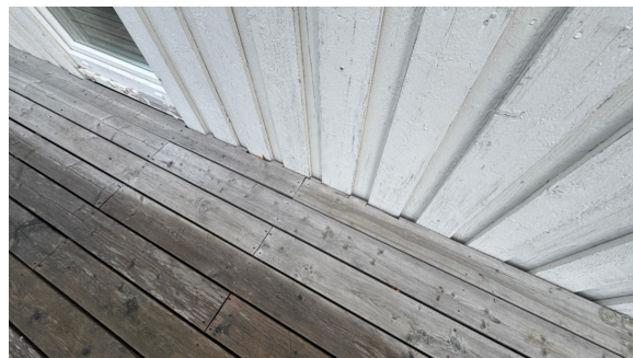
Det er ikke montert beslag mellom yttervegg og balkong/terrasse.
