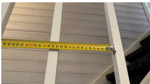
Kontroll av åpninger i rekkverk.
