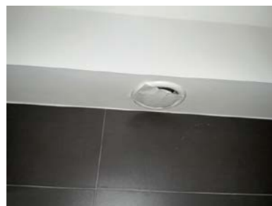
Kontroll av avtrekk.
