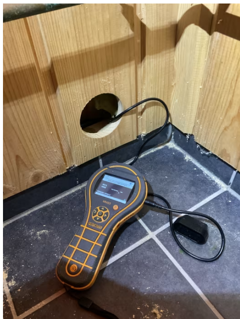
Hulltaking i tilstøtende rom.
