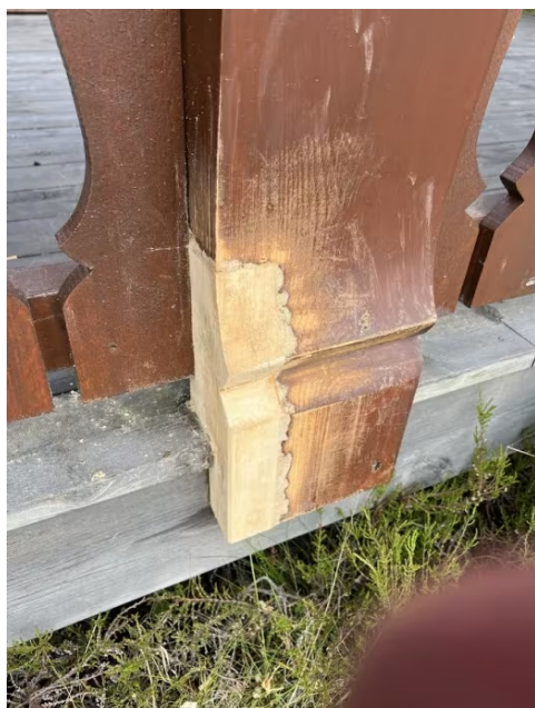
Utbedringer av råteskade.
