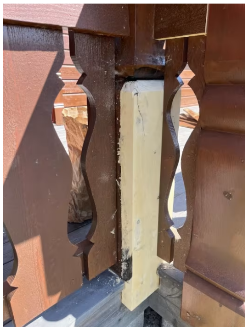
Utbedringer av råteskade.
