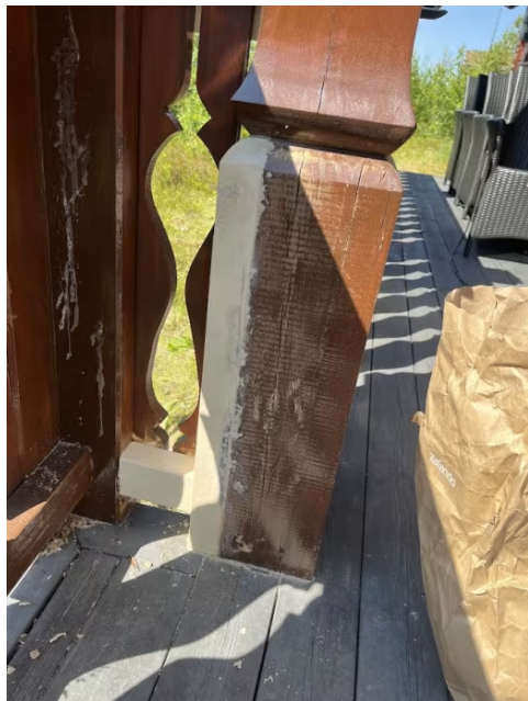
Utbedringer av råteskade.
