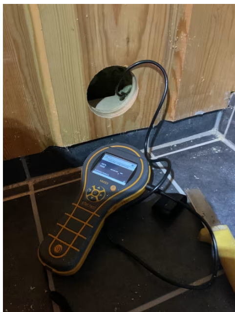
Hulltaking i tilstøtende rom.
