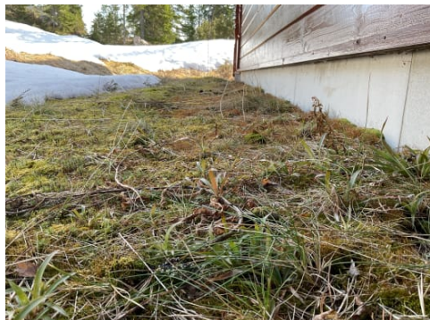
Flatt terreng på oversiden av boligen.
