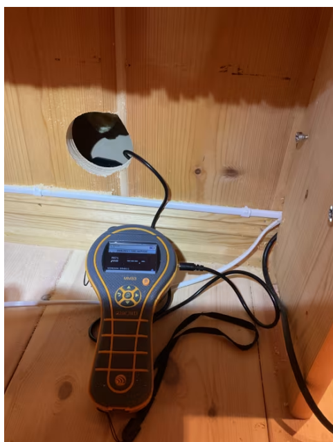
Hulltaking i tilstøtende rom.
