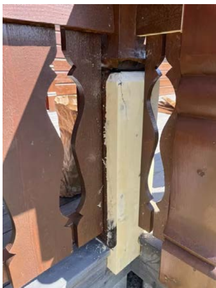
Utbedringer av råteskade.
