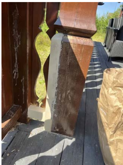
Utbedringer av råteskade.
