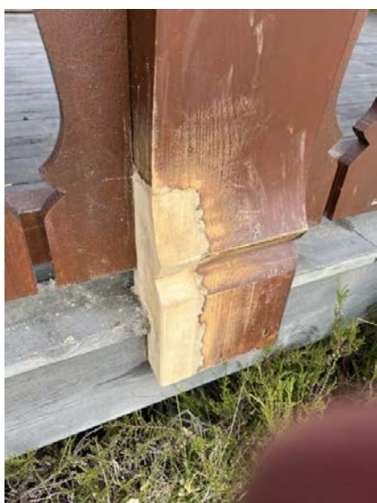
Utbedringer av råteskade.
