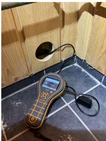
Hulltaking i tilstøtende rom.
