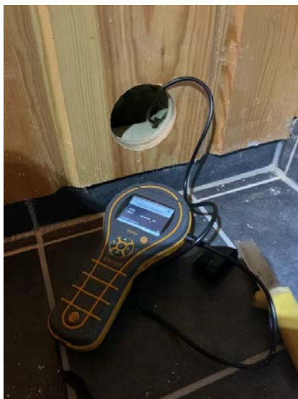
Hulltaking i tilstøtende rom.
