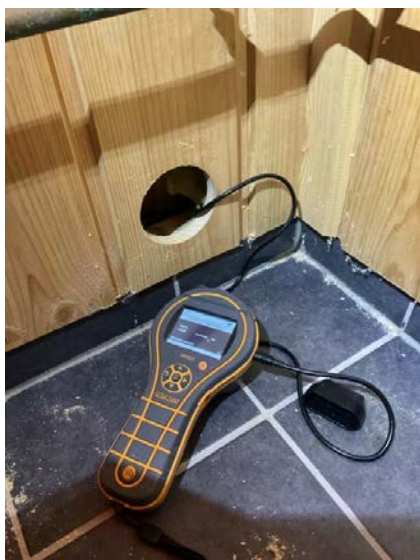
Hulltaking i tilstøtende rom.
