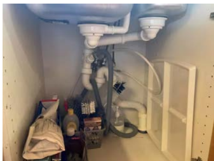
Avløpsrør for kjøkken.
