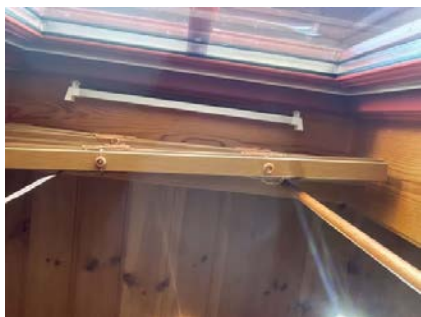
Spalteventil i vinduer.
