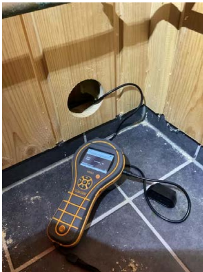
Hulltaking i tilstøtende rom.
