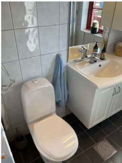
Sluk utenfor dusjsone.
