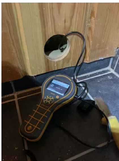
Hulltaking i tilstøtende rom.
