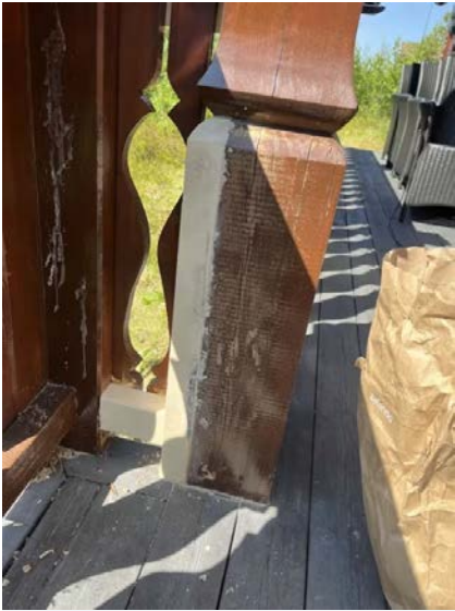
Utbedringer av råteskade.
