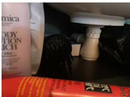
Avløpsrør for bad.
