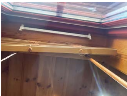
Spalteventil i vinduer.
