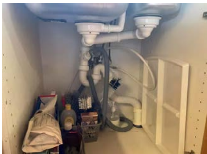
Avløpsrør for kjøkken.
