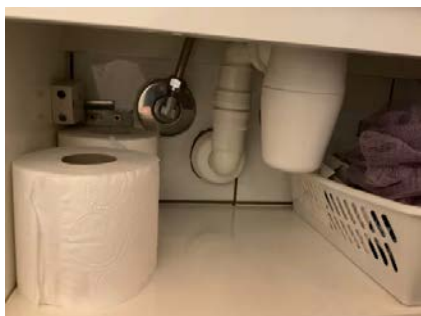
Avløpsrør for bad.
