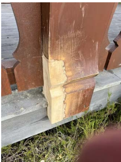
Utbedringer av råteskade.
