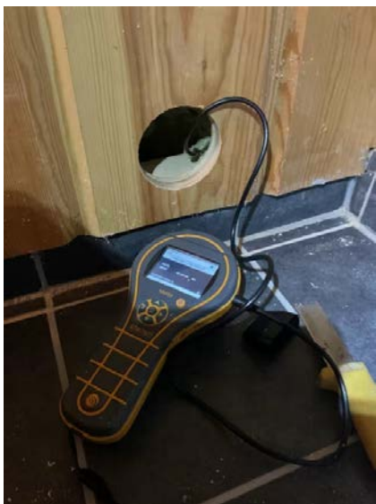
Hulltaking i tilstøtende rom.
