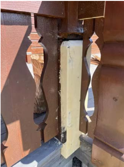
Utbedringer av råteskade.
