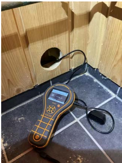
Hulltaking i tilstøtende rom.
