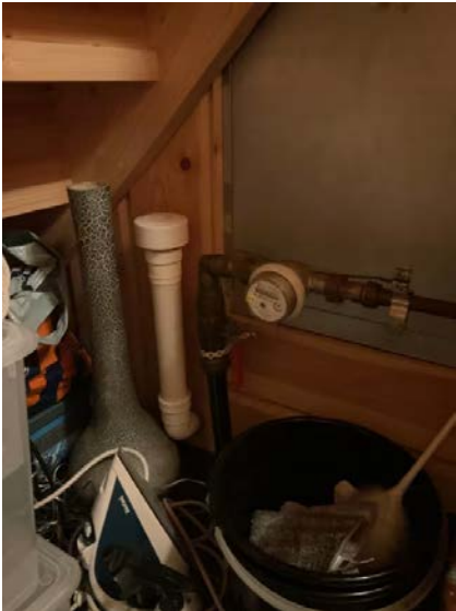
Lufting av kloakk gjennom vakuumentil.
