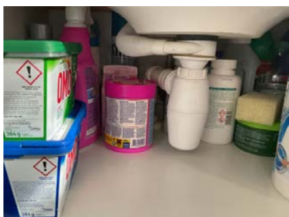
Avløpsrør for bad.
