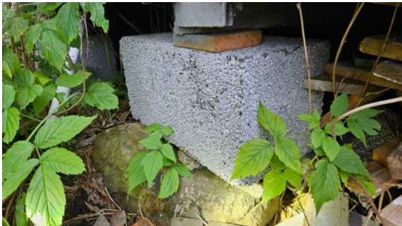
Pilar av lecastein som er kilt under.
