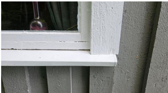
Omramming er montert helt ned mot vannbord.
