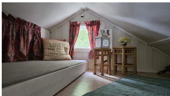
Vindu på hems er ikke godkjent som rømningsvei.
