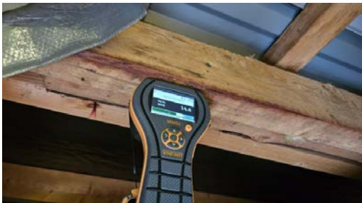
Det ble fuktmålt i takkonstruksjon, ingen forhøyede verdier ble registrert.
