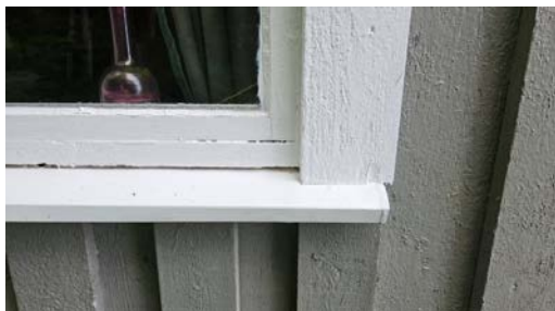
Omramming er montert helt ned mot vannbord.
