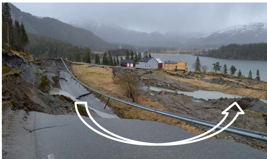
Figur 2.11: Rotasjonsskred i Tosbotn 2016. Foto: Fredrik Høgaas, NGU
