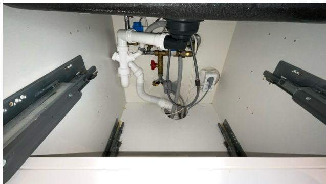
Besiktigelse av røropplegg.
