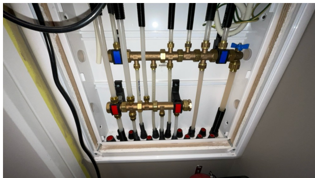
Besiktigelse av røropplegg.
