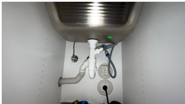
Besiktigelse av røropplegg.
