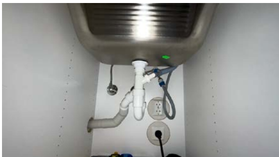
Besiktigelse av røropplegg.
