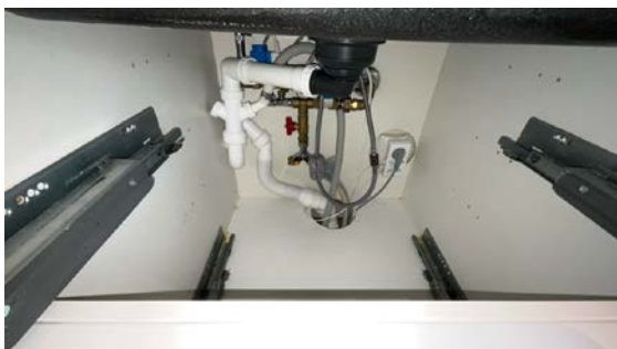
Besiktigelse av røropplegg.
