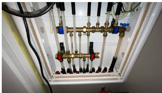
Besiktigelse av røropplegg.
